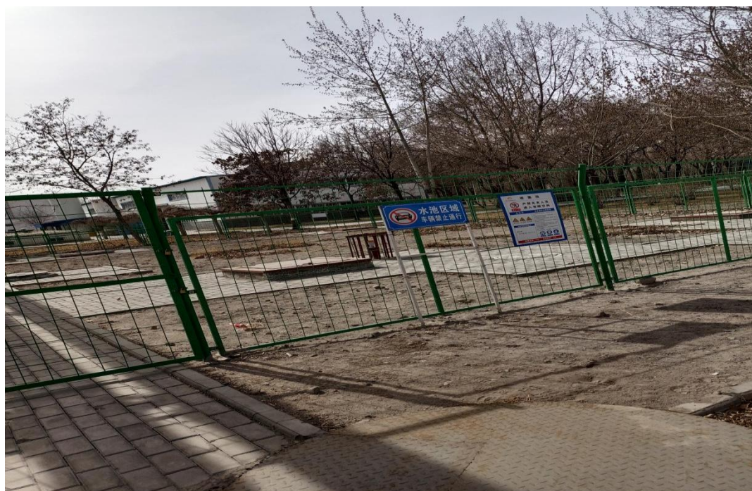
图 4-10 粉体分厂新建 350m 3 沉淀池
