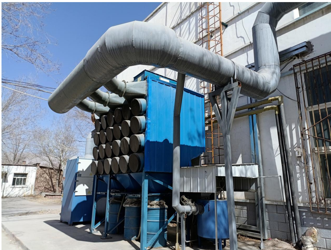
图 4-7 铍铜分厂烘烤废气处理设施
