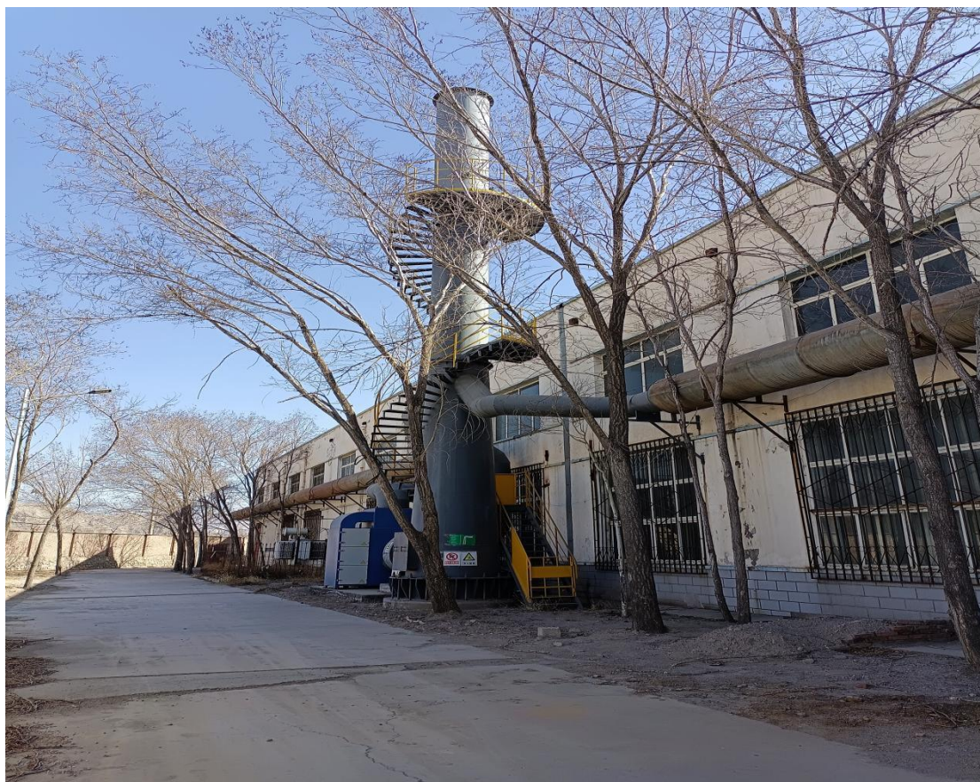
图 4-6 铍铜分厂电渣车间烘烤废气 18 米排气筒
