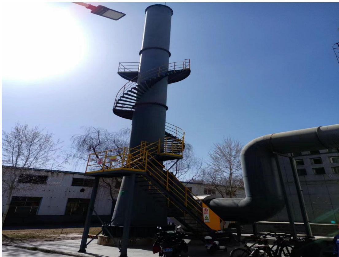
图 4-9 铍铜分厂轧制大厅新建 20 米排气筒
