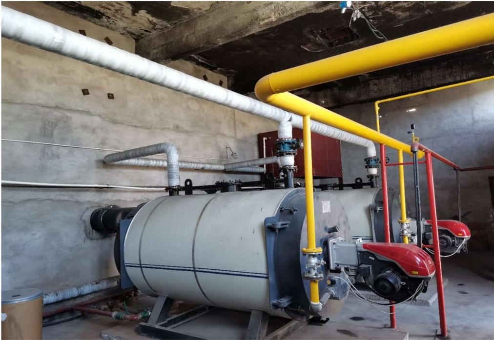
图3-1 2台燃气锅炉
