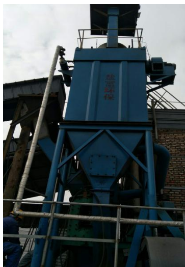
图 4-2 燃煤破碎用收尘器
