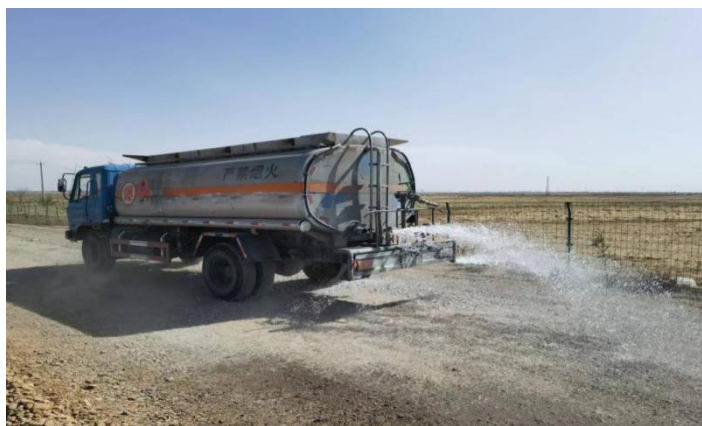
图 5-1 回填区、运输路面洒水车
