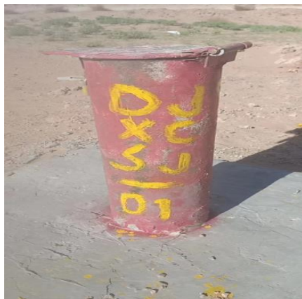
图 4-12 地下水监测井
