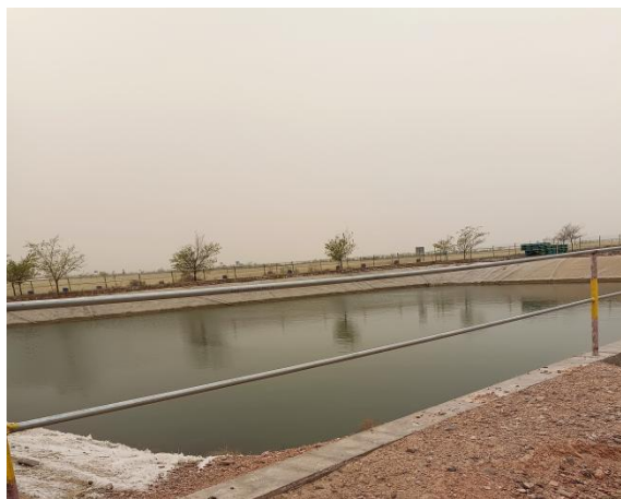
图 4-11 渗滤液收集池
