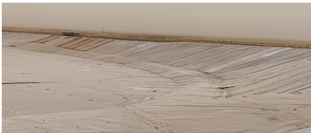
图 4-8 边坡修整及土工膜
