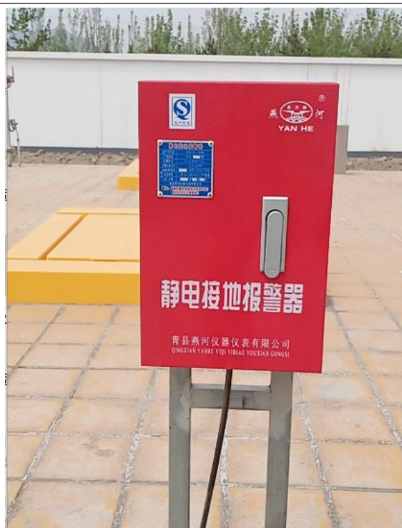
图 3-6 静电接地报警器
