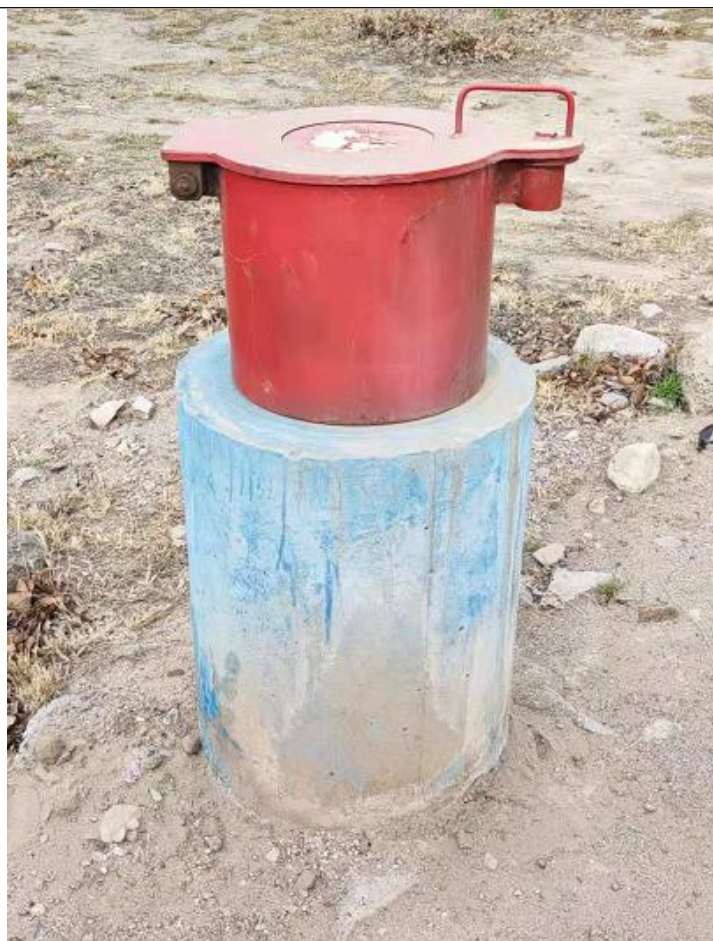
图 3-2 地下水监测井
