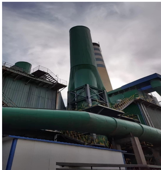
图 3-3 悬浮分离式半干法脱硫塔
