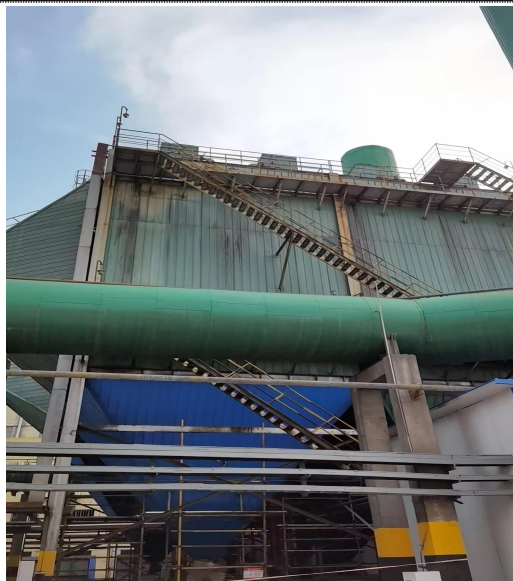
图 3-4 电捕焦油器
