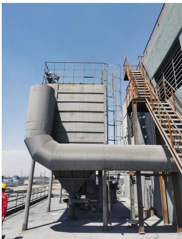
图 5-14 兰炭烘干工序布袋除尘器
