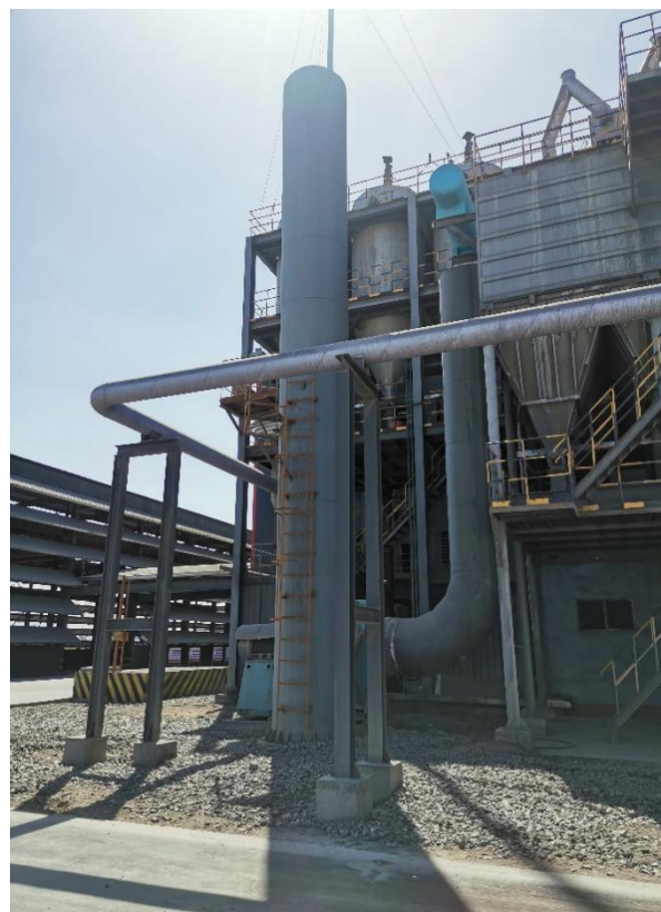
图 5-15 兰炭烘干排气筒
