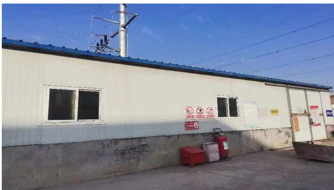
图 4-6 现有的 90m 2 废油危废暂存间
