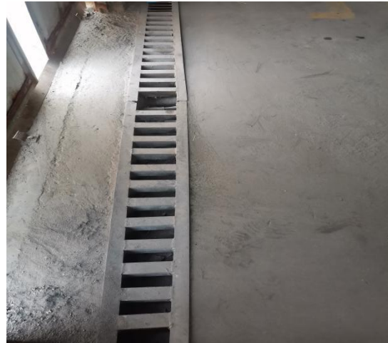
图 4-8 废油危废暂存间油库槽
