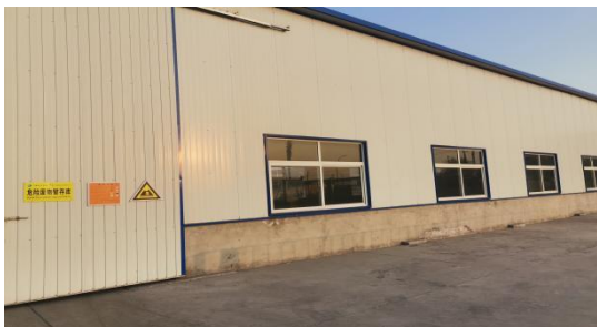
图 4-13 铝灰危废暂存间通风设施
