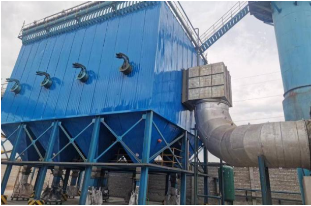
图 5-1 3#布袋除尘器+23m 排气筒
