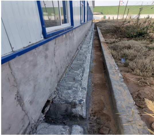
图 4-7 铝灰危废暂存间排水槽
