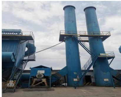
图 5-4 1#、2#除尘器 20m 排气筒
