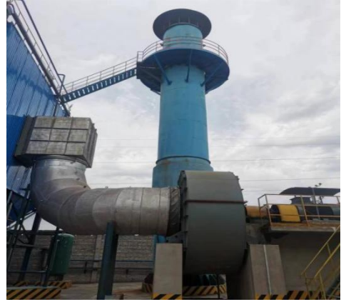
图 5-1 3#布袋除尘器+23m 排气筒
