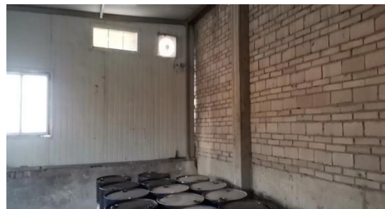
图 4-14 废油危废暂存间通风设施
