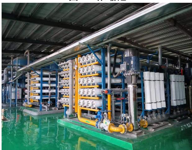
图 4-6 反渗透处理工序
