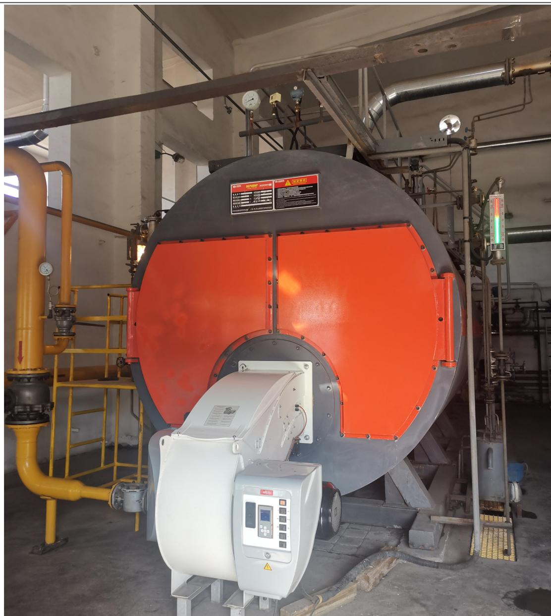
图 3-3 技改之后燃气锅炉
