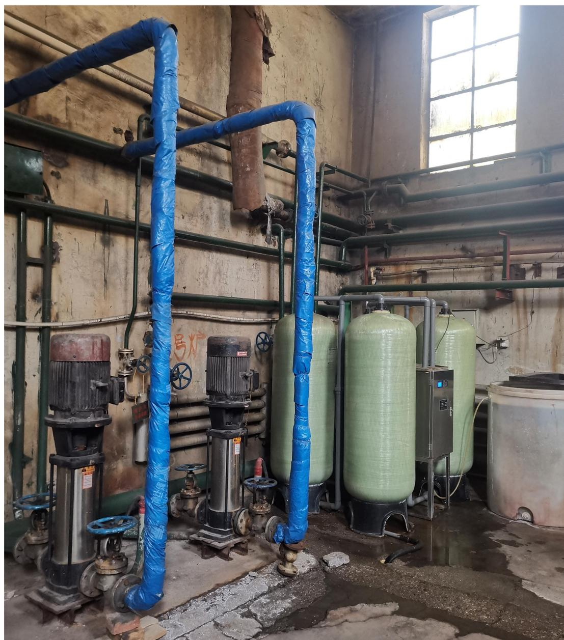
图 3-1 软水制备装置
